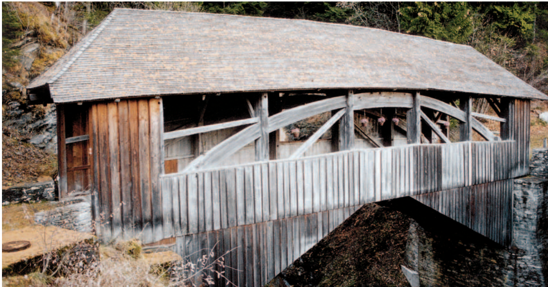
Eggatobelbrücke Churwalden/Malix, erstellt 1837 beim Bau der oberen Strasse. Heute ist die Brücke in einen kulturgeschichtlichen Wanderweg eingebunden. Restauriert 1990.
